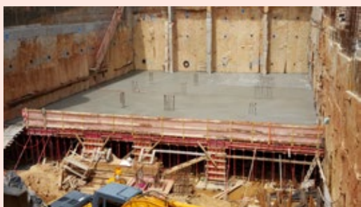
Figura 2. Trecho da primeira laje concretada.
