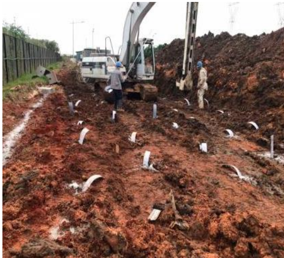
Figura 1. cravação dos geodrenos
