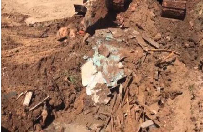
Figura 7. remoção da camada de lixo
