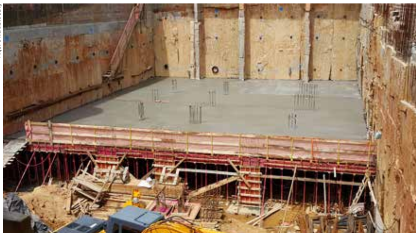
Trecho da primeira laje concretada
