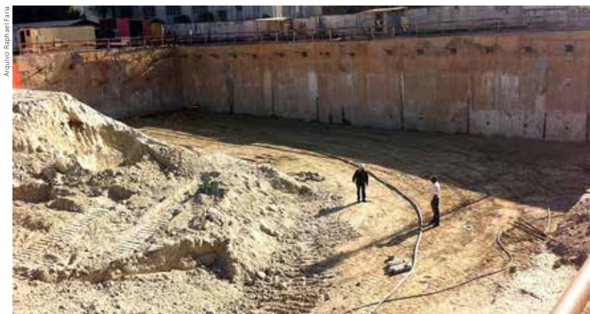
Vala a céu aberto
