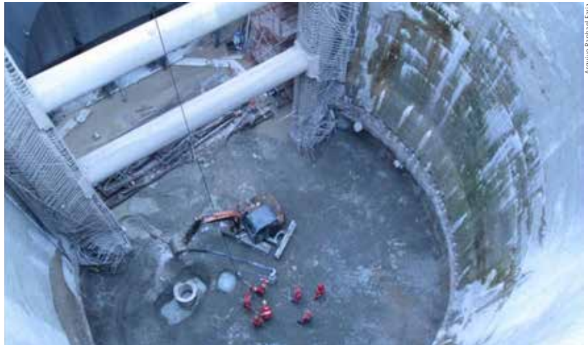
Escavação de poço secante
