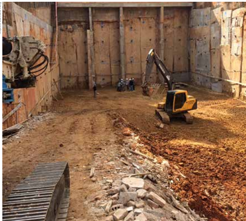
Escavação concluída do empreendimento residencial em Porto Alegre (RS)
