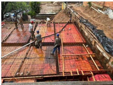
Figura 7. Execução da laje de travamento da cortina
