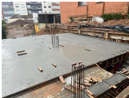
Figura 8. Laje de travamento da cortina
