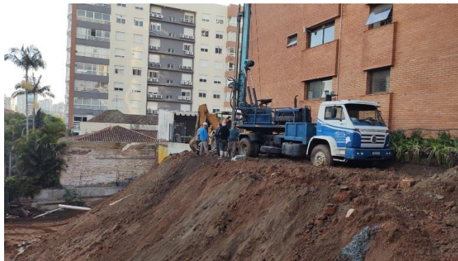
Figura 6. Foto de execução das estacas escavadas justapostas ( \varnothing 50 ), com comprimento de 15m.
